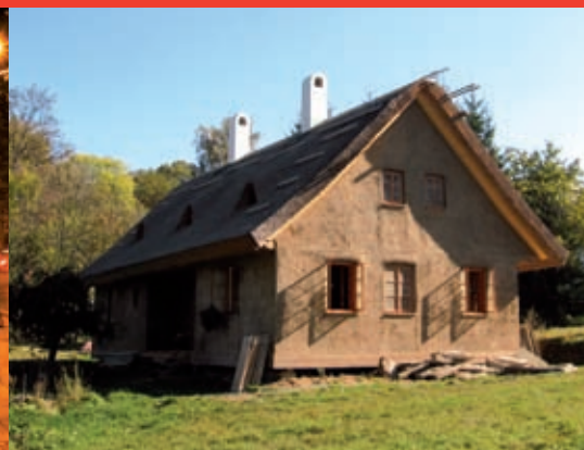
08 „Slaměnka“ - energeticky úsporný dům
