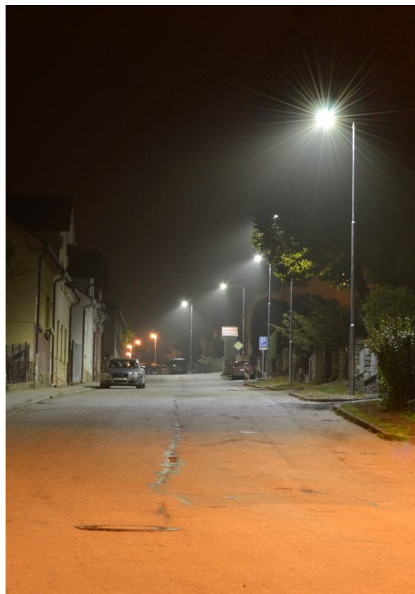
Stav po rekonstrukci
