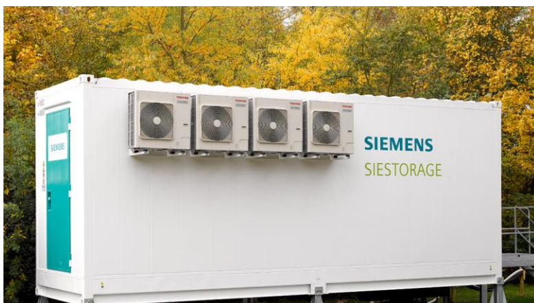
Obrázek 4: Řešení pro společnost VDL (SIESTORAGE 1,6MW / 1,3MWh)
