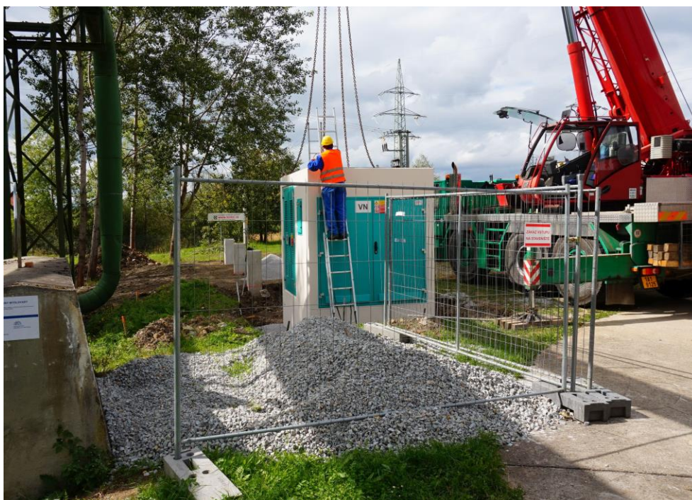
Obrázek 11: Lokality Mydlovary, instalační práce, osazování trafostanice (15.9.2017)
